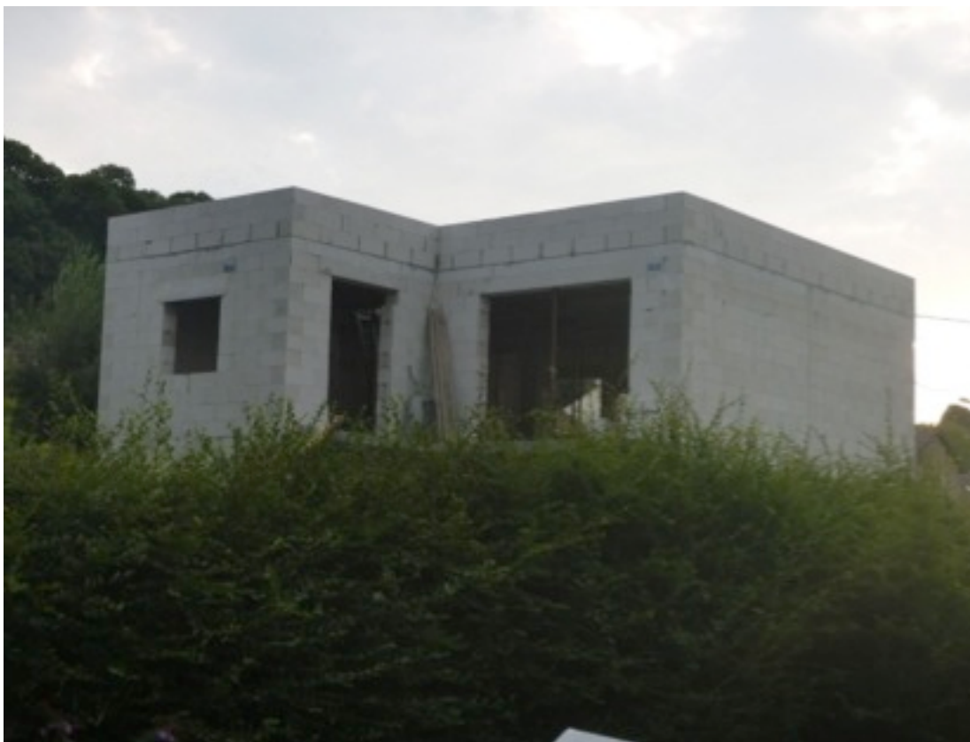
La colline de Montmorency après le permis de construire ( il manque 1,50m)
