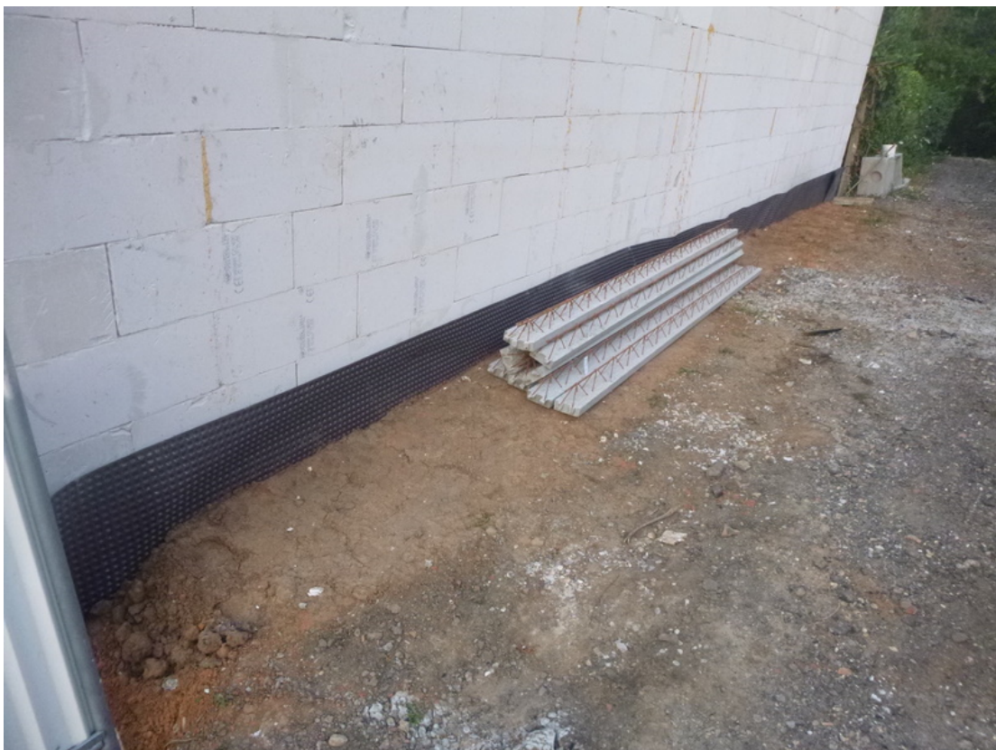
Remblaiement dans l'urgence pour masquer les 6 niveaux de parpaings
